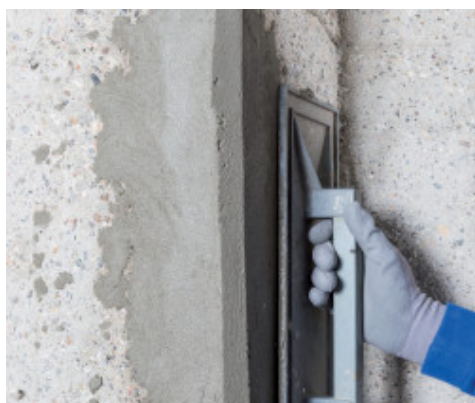
Regularização com talocha de Planitop Rasa & Ripara R4
