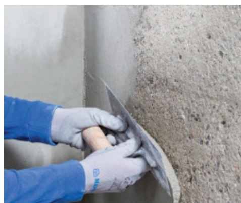
Aplicação com espátula de Planitop Rasa & Ripara R4
