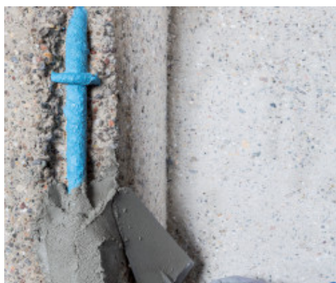
Aplicação com colher de pedreiro de Planitop Rasa & Ripara R4
