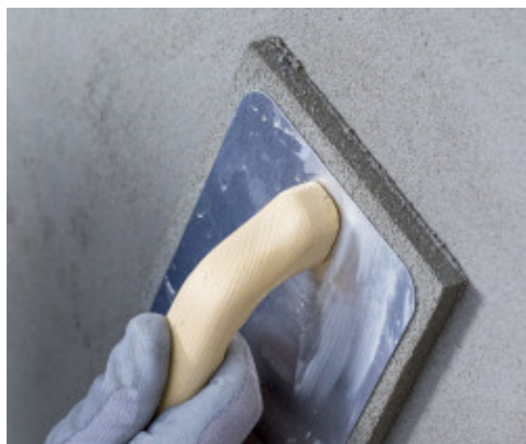
Afagamento de Planitop Rasa & Ripara R4
